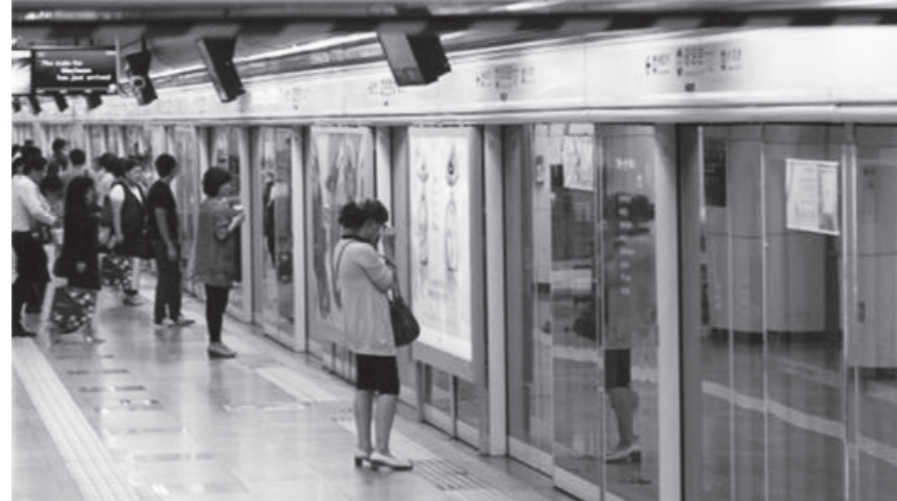
▲밀폐형 스크린 도어 앞에 편안하게 서서 지하철을 기다리는 서울시민들. 스크린 도어 시스템 도입 이후 지하철 승강장 추락사고가 근절되었다.
